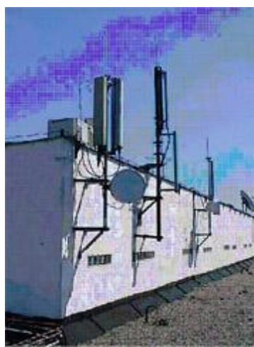
b) anteny nadawcze telefonii komórkowej
