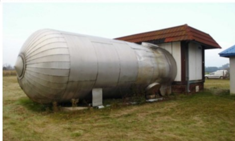
Stacja uzdatniania wody w Augustynowie przed remontem
