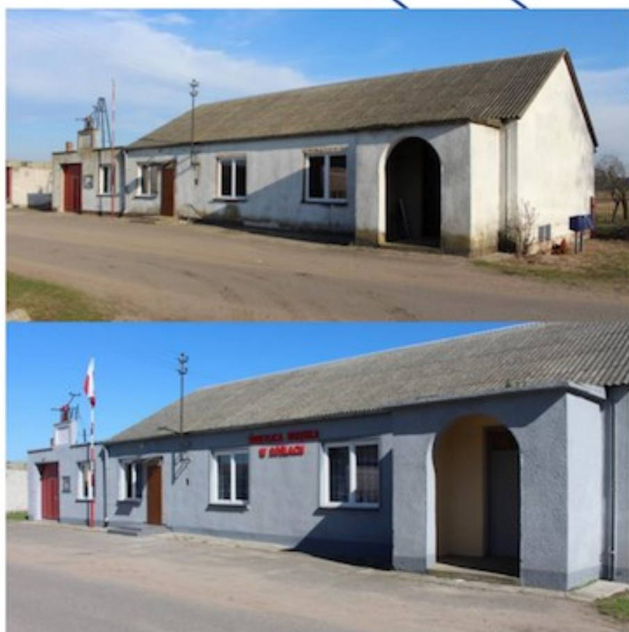
Remont świetlicy w Roślach
