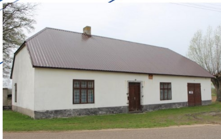
Wyremontowany dach świetlicy w Augustynowie
