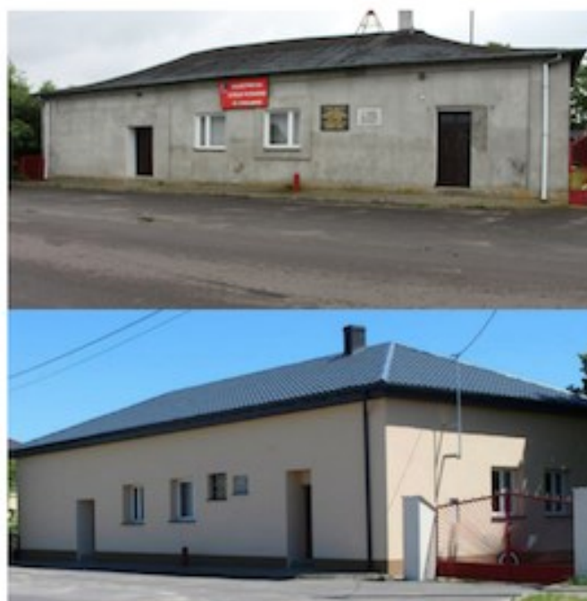
Świetlica w Chełmnie przed i po remoncie
