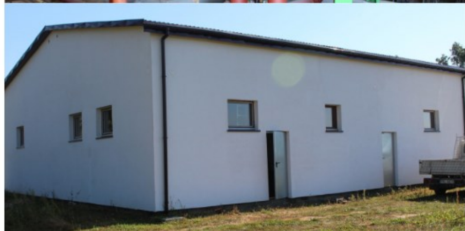
Stacja uzdatniania wody w Augustynowie
