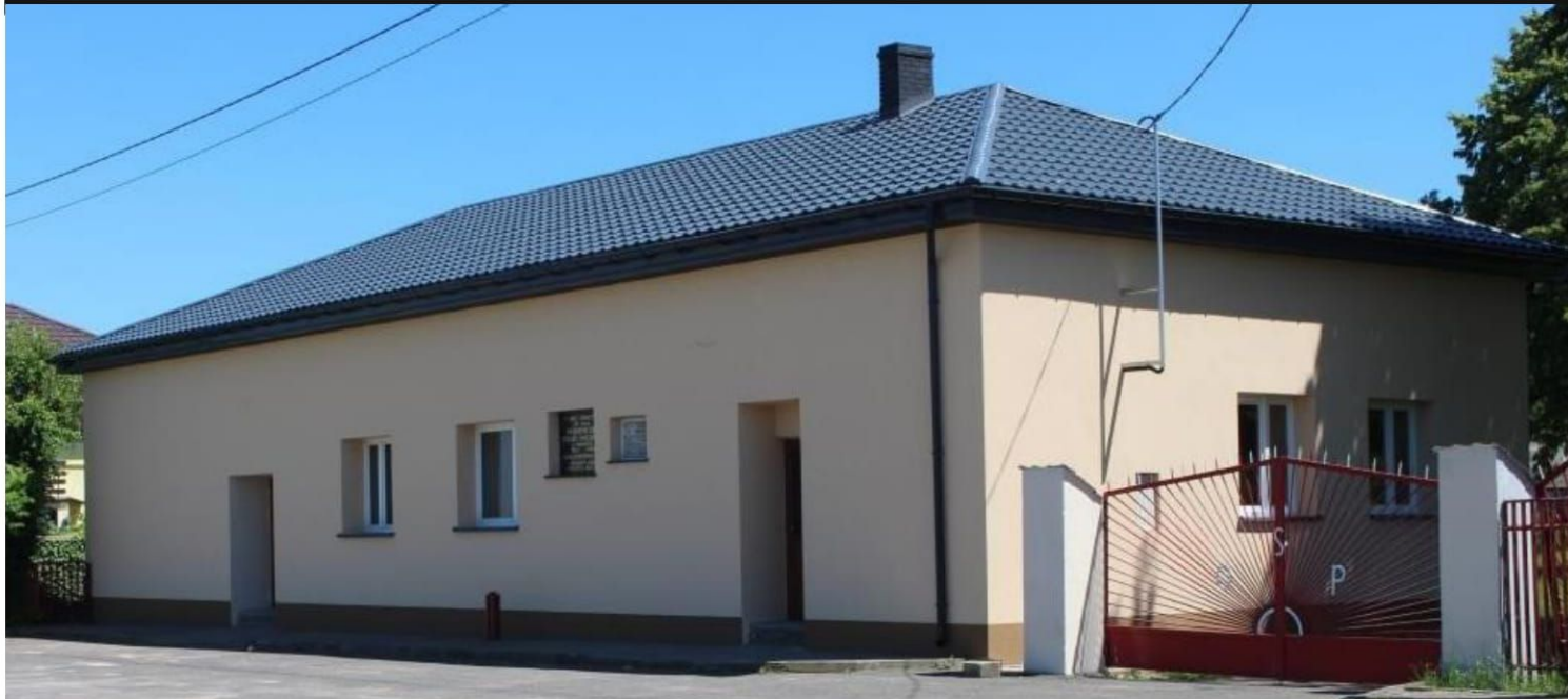
Świetlica OSP w Chełmnie po remoncie
