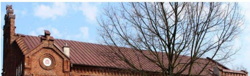
Planowana wymiana pokrycia dachowego
