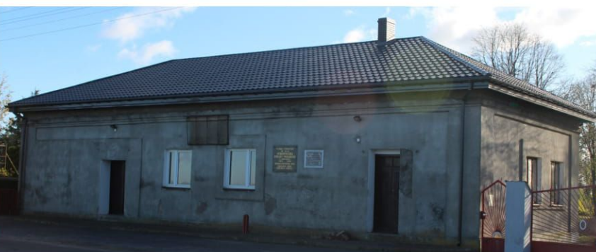
Świetlica przed remontami
