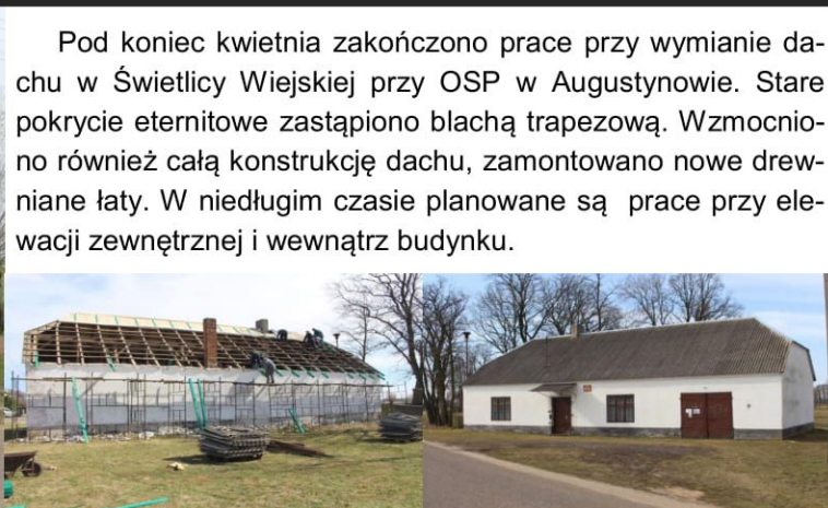
Świetlica w trakcie prac
