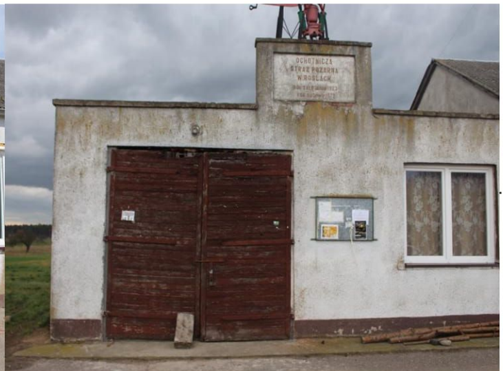
Świetlica przed remontem
