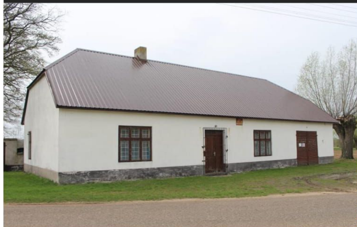
Dach po remoncie
