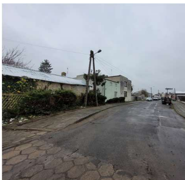
Zdjęcia terenu – widok z drogi powiatowej, ul. Nadzeczna
