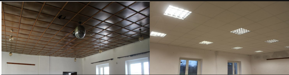
Sufit w głównej sali remizy przed i po remoncie
