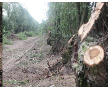
Zdjęcia z budowy nowej drogi w Karszewie
