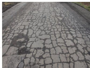
Droga przed remontem
