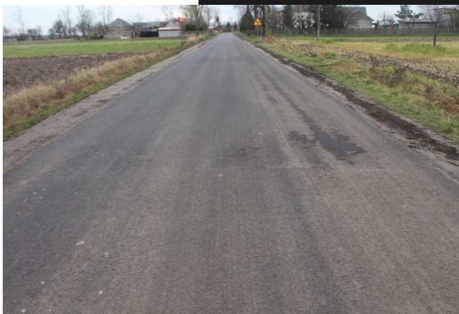
Droga po remoncie
