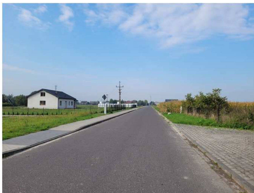
Zdjęcie nr 5 Widok z ulicy Ogrodowej na budynek w budowie (brak na mapach)
