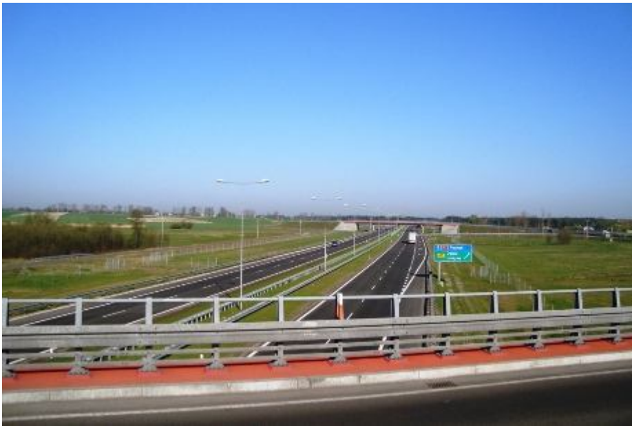
Autostrada A2 węzeł Dąbie
